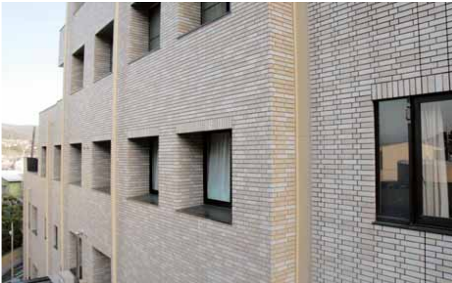
(E棟北面:外壁鉄筋コンクリート増設(55cm)補強工事)
