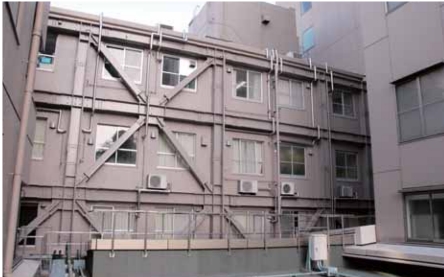
(D棟西面:外壁鉄骨フレーム増強工事)
